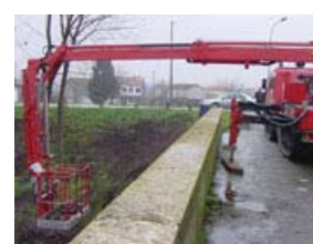
Piattaforma aerea con braccio sottoponte
