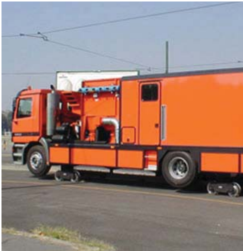
Veicolo strada-rotai in fase di molatura
