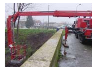
Piattaforma aerea con braccio sottoponte
